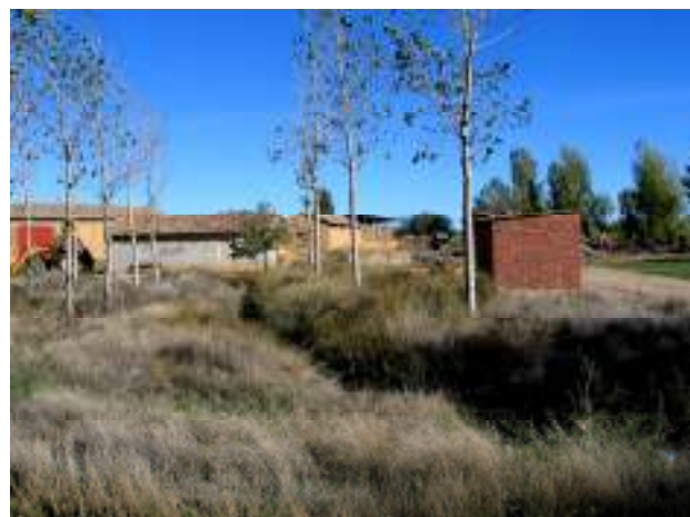
Vista general de los suelos localizados en la manzana 12665. Foto realizada desde el Norte.
